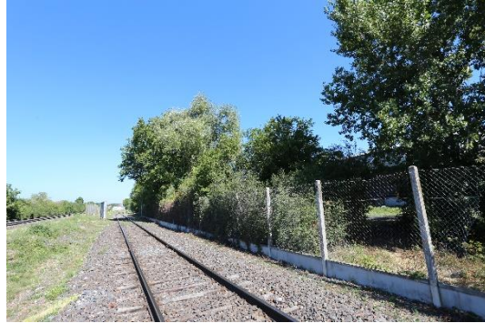
Voie de chemin de fer (21/08/23)
