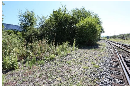
Friche rase le long de la voie ferrée (21/08/23)
